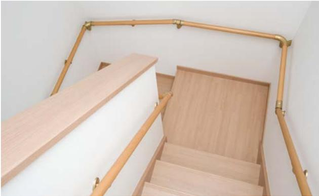
※転倒・転落を防ぐため、階段などの段差付近や足元が滑りやすい場所では、必ず手すりを連続させてください。
