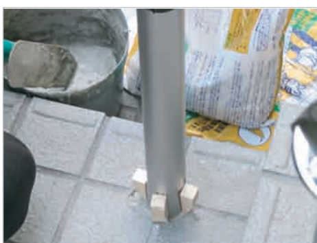
⑤ モルタルを流し込みます。
