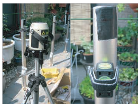
④ 支柱の垂直を確認します。
