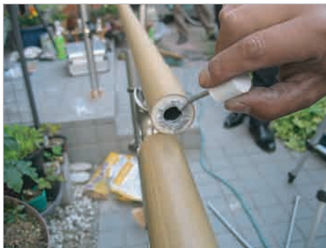
② 錆び止めペンキを塗ります。
